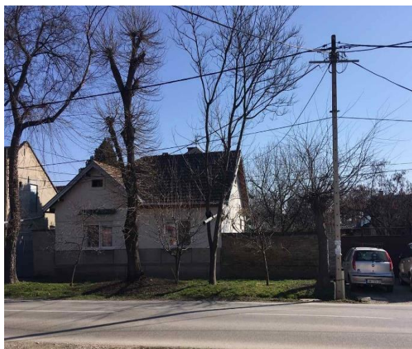
Pogled na stambenu kuću
